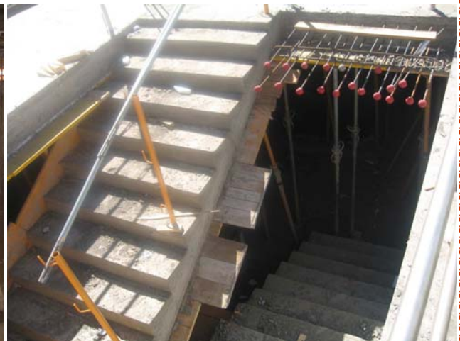
Escalera de bajada al sótano
