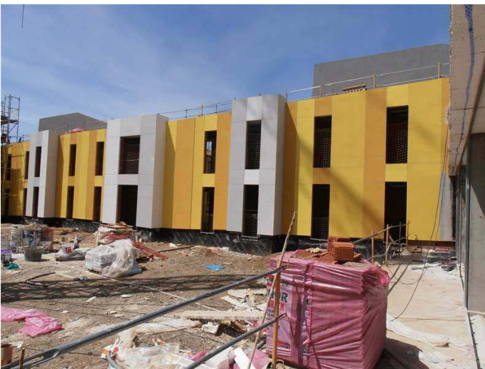
Galería Oeste. Vista desde Patio Interior
